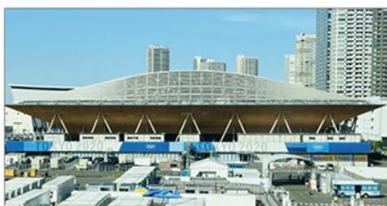
un ruolo fondamentale. Secondo gli architetti la struttura dovrebbe somigliare a una "nave che galleggia nella baia". Le pareti esterne sono realizzate in cedro, mentre il tetto è in larice; in totale sono stati utilizzati 2.300 metri cubi di legno provenienti da diverse aree del paese. In grado di ospitare fino a 12.000 spettatori, rimarrà purtroppo desolatamente vuoto, a causa dell'emergenza sanitaria. Al termine dei Giochi l'impianto è stato trasformato in un centro congressi.
